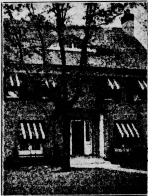
Les auvents sont indispensables au cours de la saison d'été. Ils aident non seulement à garder la température fraîche à l'intérieur du logis, mais empêchent encore le soleil de brûler draperies et rideaux et ils ne déparent en rien, comme on peut en juger par la photographie ci-contre, l'apparence de la maison.
