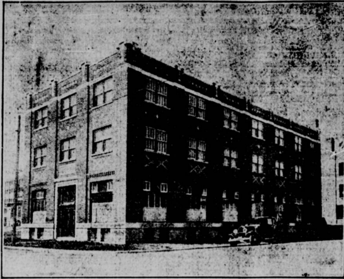
Le nouvel édifice pour les pièces des voitures Chrysler, Plymouth, Dodge, DeSoto, ainsi que pour les camionnettes Dodge et Fargo que l'on vient d'ériger à Régina. Les provinces de l'ouest seront ainsi mieux servies et pourront obtenir quelque chose de ce soit à un maximum de 48 heures.
