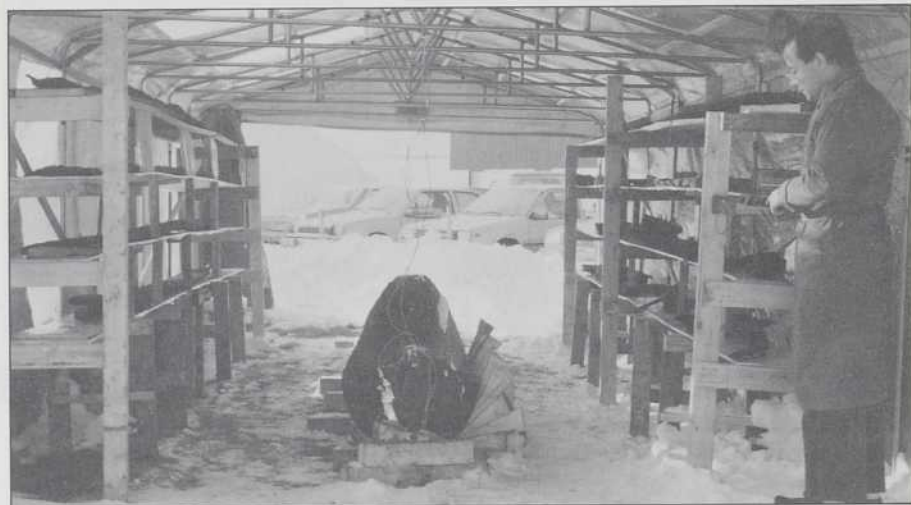
Sur les tablettes latérales de la tente, les vestiges d'une embarcation; au centre, une pirogue découverte dans un lac du nord de Montréal. On mesure la température du bois, en surface et en profondeur.
