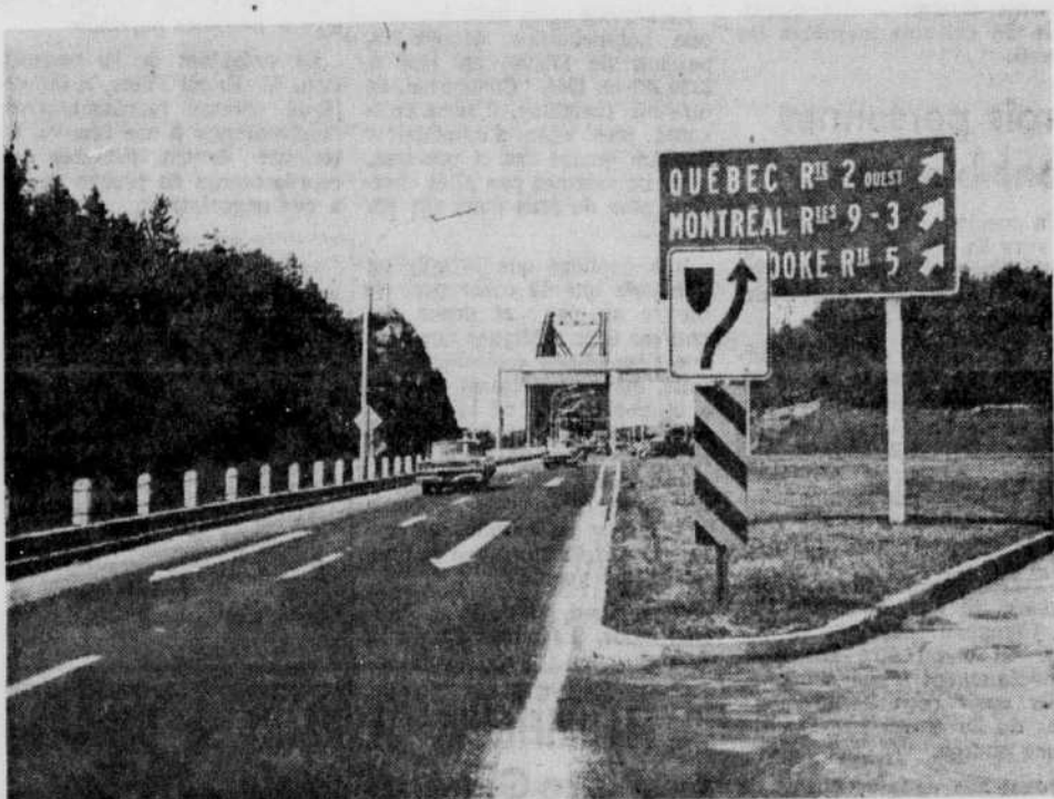
CHAUSSEE A DEUX VOIES — Depuis quelques jours les automobilistes qui sortent du pont de Québec en direction de Lévis ou ceux qui, venant de Montréal, se dirigent vers la Gaspésie n'ont plus à "subir l'étranglement de la chaussée", avant de s'engager sur le pont de la rivière Chaudière. La voirie provinciale a exécuté les
