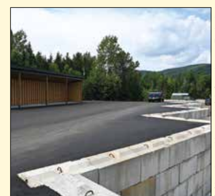
Les nouvelles baies d'entreposage et le préau.
