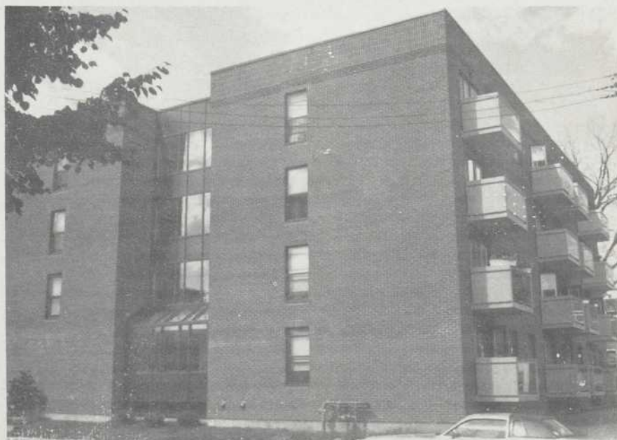
Façade sud. On remarque la fenestration maximale qui donne un éclairage naturel aux corridors.
