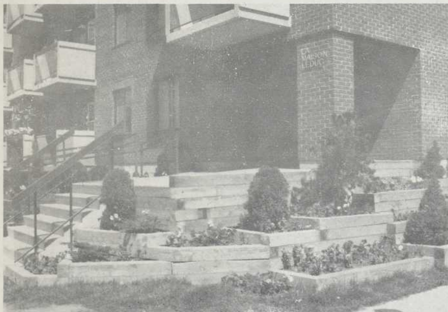
Entrée de la maison Leduc. On a évité la porte centrale trop "institutionnelle". L'entrée est spacieuse, munie d'une rampe d'accès à pente douce et d'un escalier qui reprend les détails des balcons.
