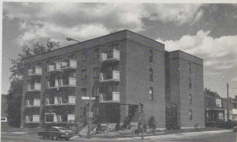
Vue d'ensemble du projet. A noter la corniche, les linteaux et les détails des balcons.
