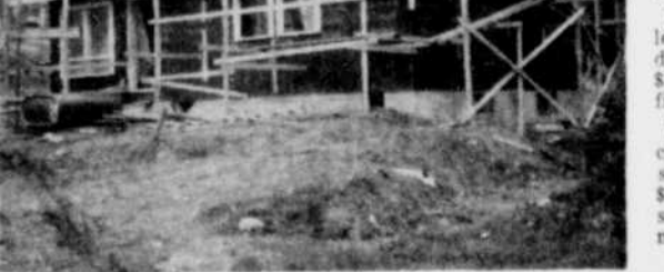
POUR LA FAMILLE DUPRE. — D'ici quelque temps, les membres de la famille Gérard Dupré pourront déménager dans leur nouvelle demeure, rue Lemaire, à Sherbrooke. On sait que cette maison a été construite grâce à la collaboration et à la générosité de plusieurs personnes de Sherbrooke, à la suite de l'incendie qui avait détruit la demeure de la famille Dupré. (Photo La Tribune, par Studio Breton)
