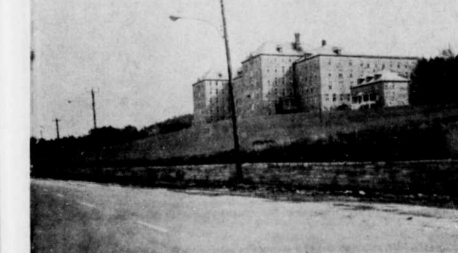
UNE PARTIE DU MUR EST TERMINEE. — Les travaux en vue de la construction d'un mur rue Galt Ouest sont en partie terminés. Ce mur s'élève en face de la résidence des Soeurs de la Ste-Famille. (Photo La Tribune, par Studio Breton)
