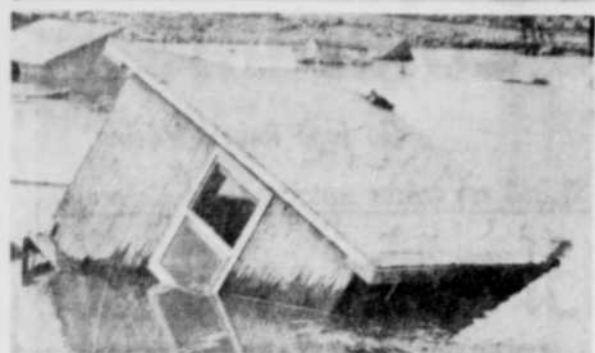
QUE D'EAU! QUE D'EAU! — St-Timothée, à 20 milles au sud-ouest de Montréal a été la scène d'une inondation éclair quand, une vanne du lac St-Louis a été ouverte accidentellement, au chantier de l'Hydro-Québec. (Téléphoto PC)
