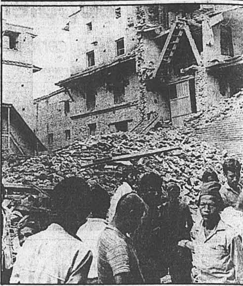
Le séisme a ébranlé une bande de territoire de 1600 km au Népal et dans l'est de l'Inde, faisant au moins 500 morts. PHOTO AP
