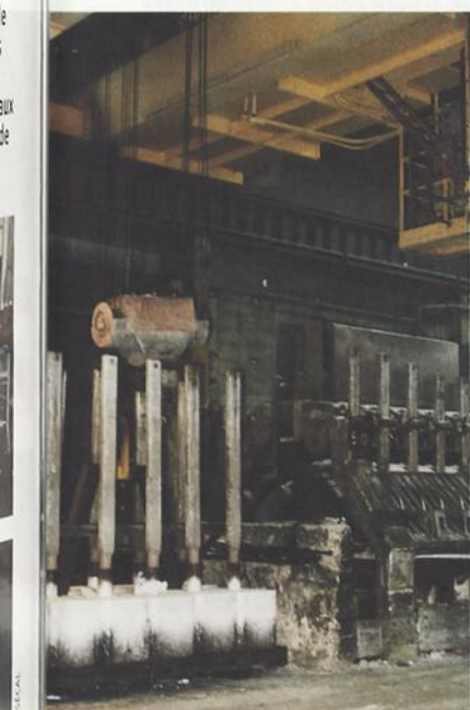
Dans les salles de cuves de deuxième génération, un pont-roulant sophistiqué pour manipuler les anodes servant à l'électrolyse de l'alumine.
