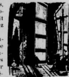
Pose des châssis (entr'acte)
