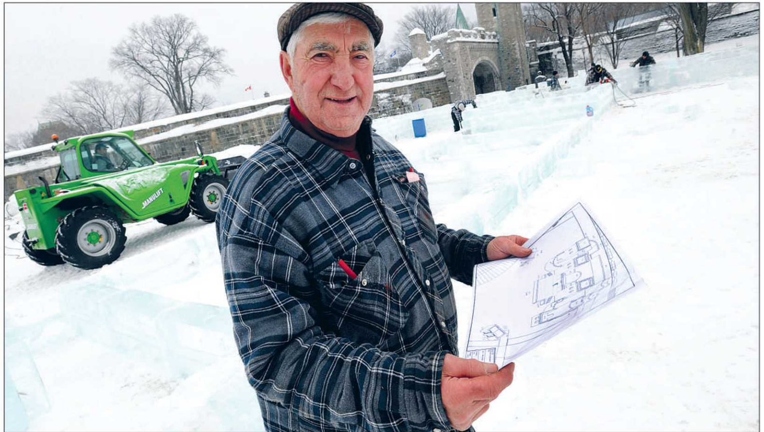
Âgé de 78 ans, Gaston Fortier supervise depuis lundi la construction de son 52 e palais de glace, résidence officielle de Bonhomme Carnaval.
