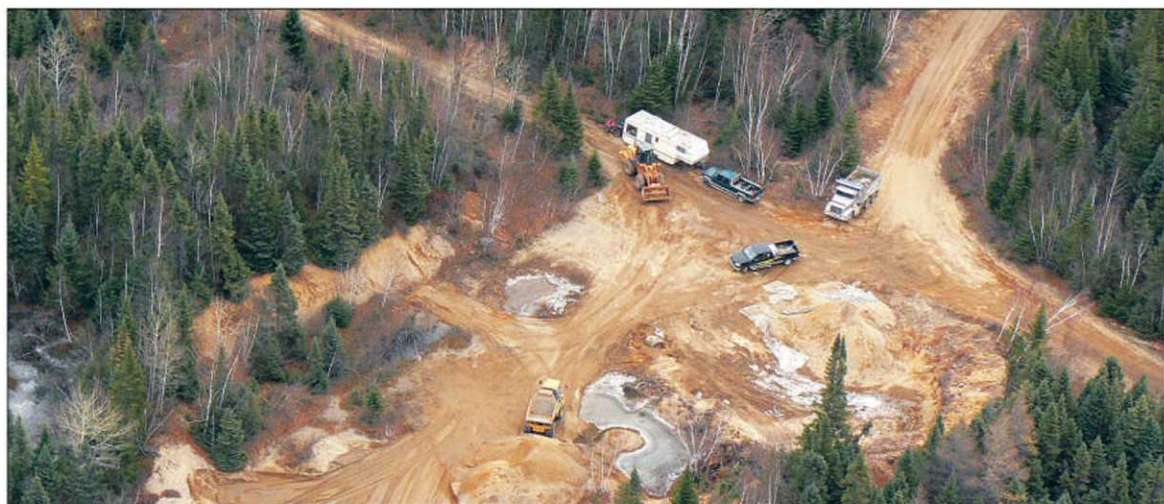
La construction du chemin d'accès à l'éventuelle mine, cet été, avait alerté les opposants au projet. — PHOTOTHÈQUE LE SOLEIL
