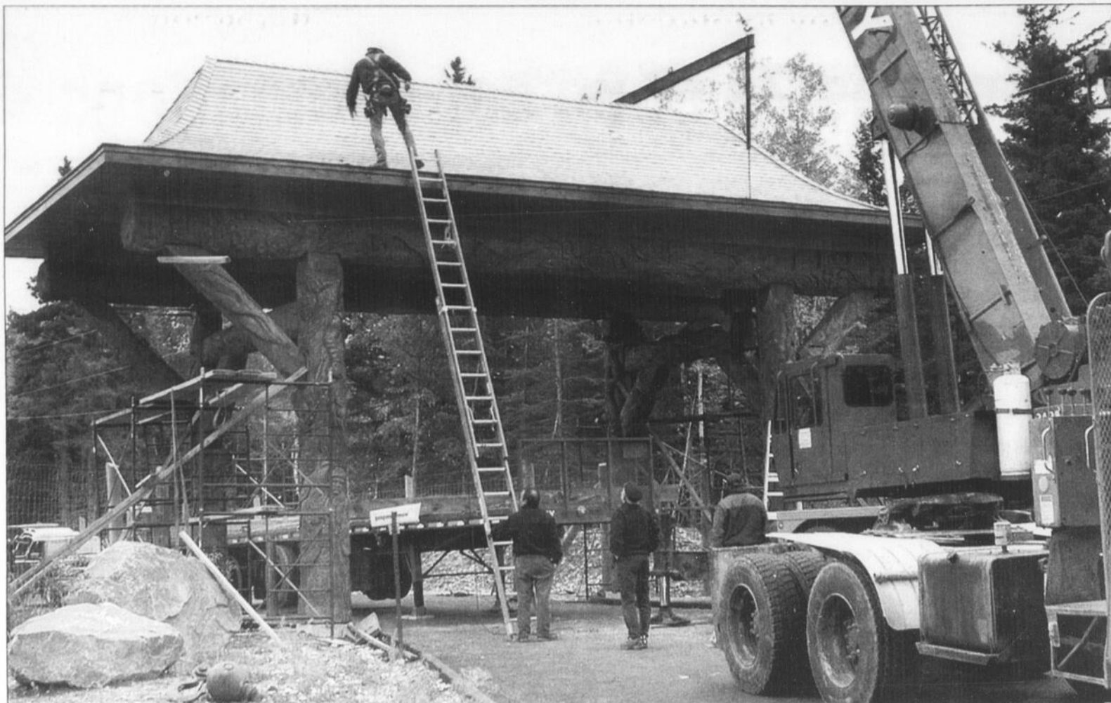
MONTAGE - L'assemblage du portail sculpté par Vic Dallaire a nécessité l'intervention d'une grue. Chaque côté du portail pèse près de 5000 livres, et son toit, 20 000 livres.
