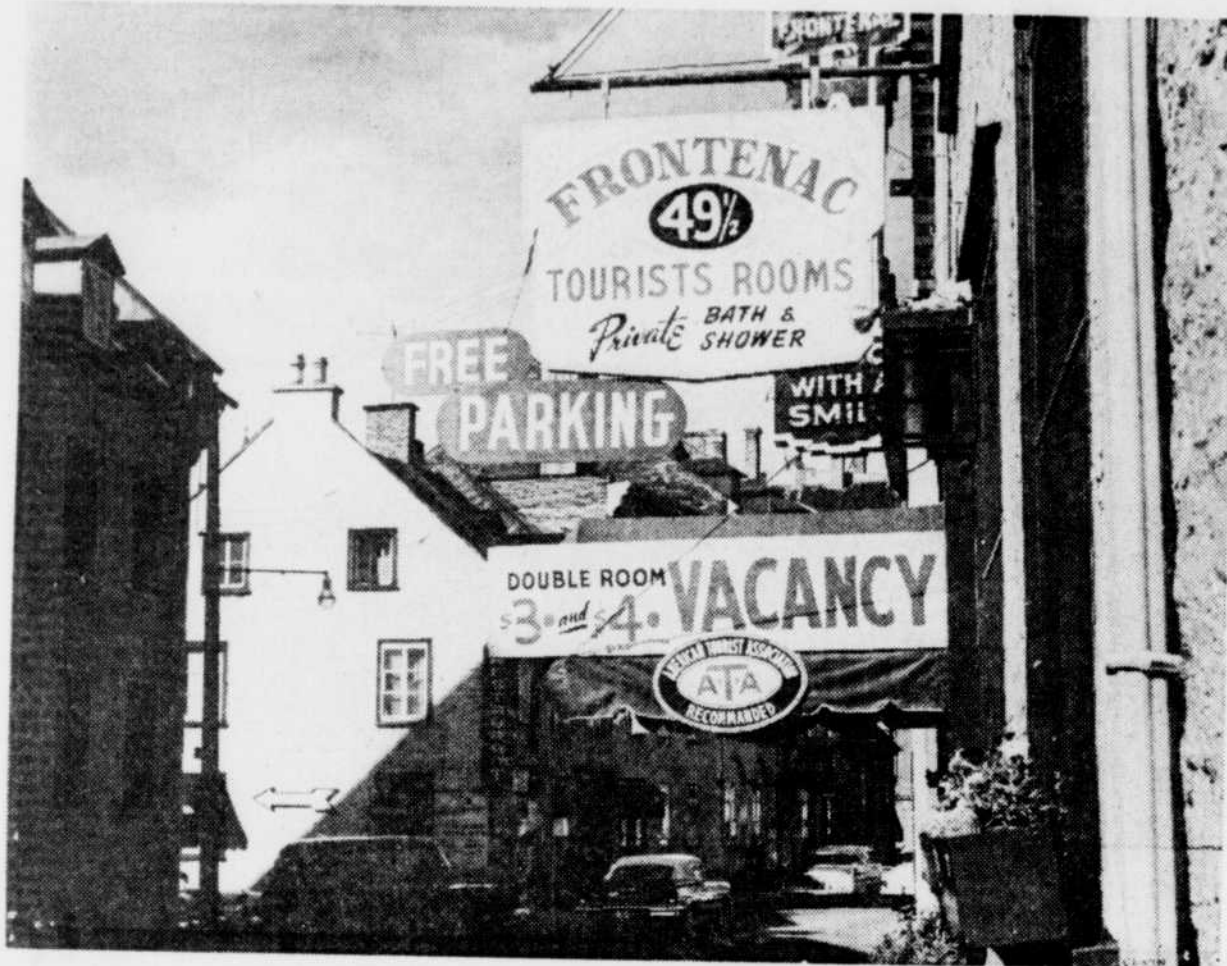
Finie l'anarchie dans le réaménagement à Québec, et particulièrement entre les limites de la cité historique.
