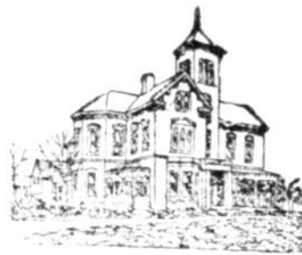
Ancien château de feu E. B. Eddy
