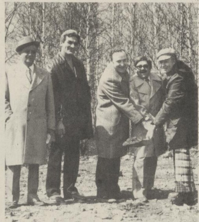
Une première pelletée qui mènera loin la compagnie Devden Industries Ltd, selon les dirigeants de l'entreprise, qui implantent leur première usine dans le parc industriel de Granby. Sur la photo, nous voyons, de gauche à droite: M. P.-Horace Boivin, commissaire industriel de la ville; M. Léon Dupuis, entrepreneur qui a obtenu le contrat de construction; M. Dennis Gustard, secrétaire-trésorier de la compagnie; Grégoire G. Lewenstein, président de Devden Ltd, et le maire de Granby, M. Paul-O. Trépanier. (Photo Jeannot Petit)
