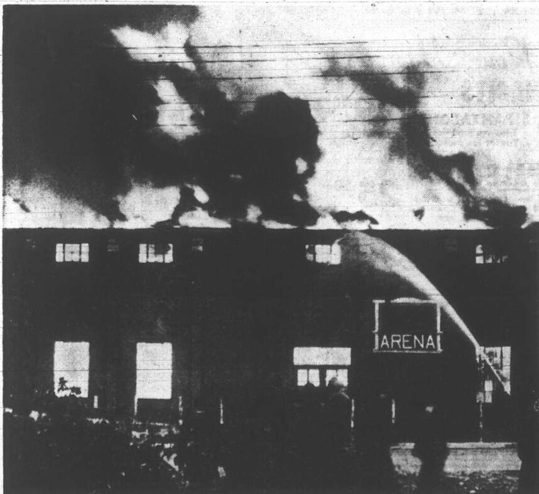
ARENA DETRUITE PAR LES FLÂMMES — Les flammes viennent de détruire l'aréna de la ville d'Oshawa, en Ontario. On évalue les dégâts à près d'un demi-million de dollars. C'est une très mauvaise nouvelle pour les amateurs de hockey qui s'attendaient à une autre belle saison.
