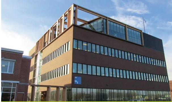
LÉONARD 2017 – RELÈVE DU GÉNIE-CONSEIL CONSTRUCTION DU CENTRE DE SERVICES DE REVENU QUÉBEC À SAGUENAY, PAR JONATHAN VIGNEAULT, ING.
