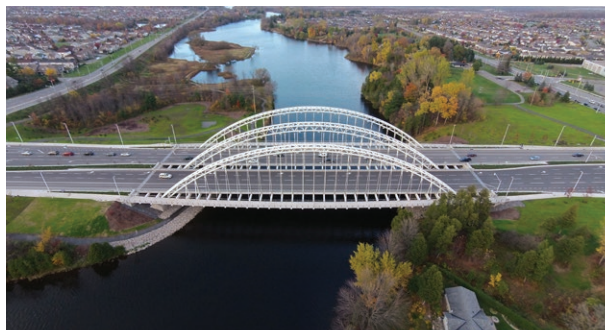
LÉONARD 2017 – INFRASTRUCTURES DE TRANSPORT NOUVEAU PONT COMMÉMORATIF VIMY
