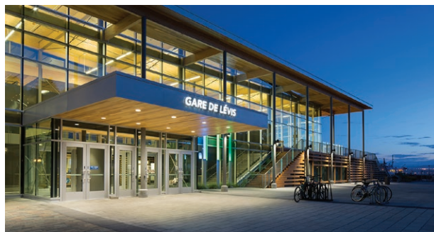
LÉONARD 2017 – INFRASTRUCTURES URBAINES RÉAMÉNAGEMENT DE LA GARE FLUVIALE DE LÉVIS
