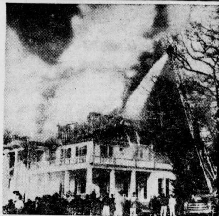
ECOLE RAVAGEE PAR LE FEU A KISKI, PENN. — Les pompiers inondent ici le brasier qu'est devenue l'école préparatoire de Kiski, l'une des mieux connues de l'Etat de Pennsylvanie, alors que les flammes ravagent cet édifice. Vingt-deux étudiants et plusieurs professeurs ont pu s'échapper indemnes de l'édifice. Les flammes y ont fait rage pendant plusieurs heures.
