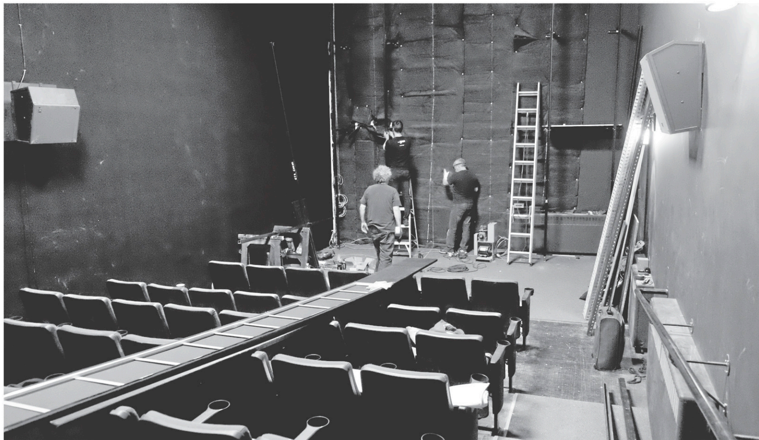
Mercredi, des ouvriers s'affairaient à installer l'écran de projection d'une des nouvelles salles. — PHOTOS ALAIN DION
