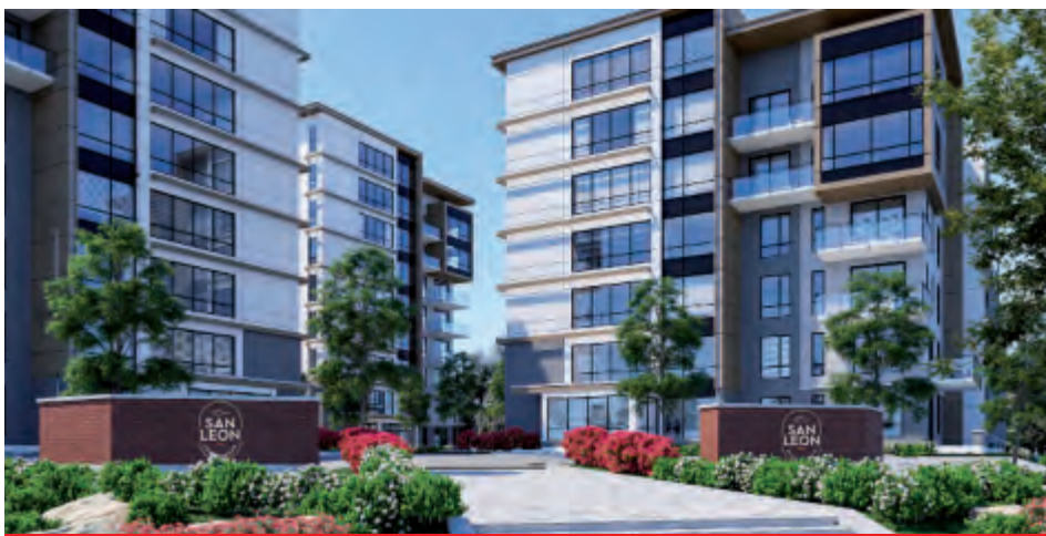
La troisième phase du San Leon est en cours de construction.
