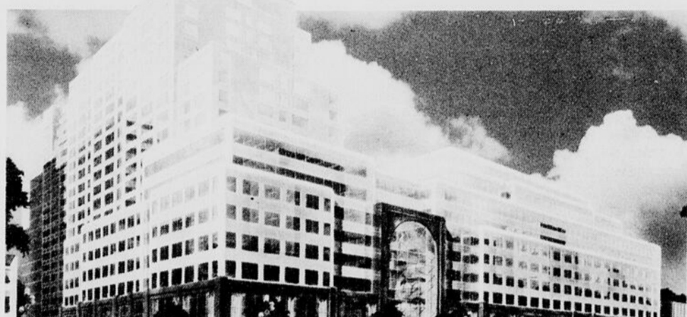
Le complexe du Fort compte quelque 500 000 p 2 de superficie. La moitié du coût total du projet, évalué à 65 M$, a été financée par le Groupe Collège Lasalle.
