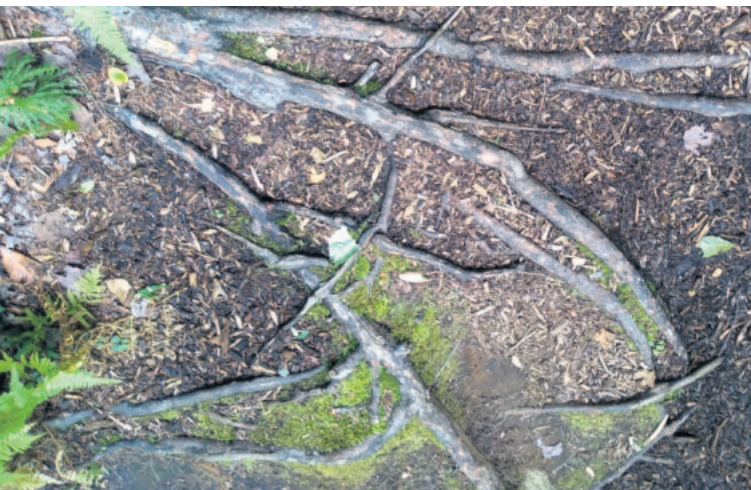
Des racines exposées en surface sur un monticule de terre dans le sentier. Ces racines sont très endommagées par l'achalandage du sentier
