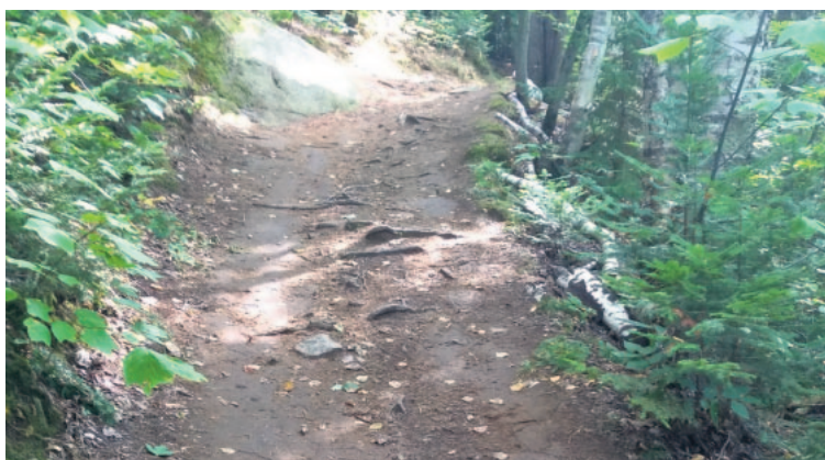
Courte descente avec pente de 15 % – On remarque l'érosion qui s'accroît dans le creux au centre de la piste, quelques grosses racines mises à nu de la piste et le bourrelet de terre en bordure côté droite qui retient l'eau de ruissellement dans la piste (sentier aménagé avec une mini-excavatrice)
