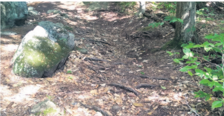
Pente de 10 % – On remarque la forte érosion au centre de la piste, les racines en surface et la bordure surélevée à droite qui retient l'eau de ruissellement dans la piste.
