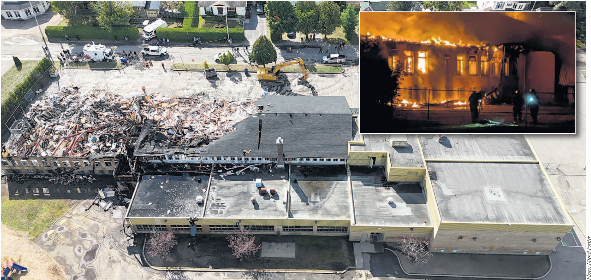
On présume pour l'instant que l'incendie a pris naissance à l'arrière de l'école, près de la porte 10 (visible à gauche sur la photo).
