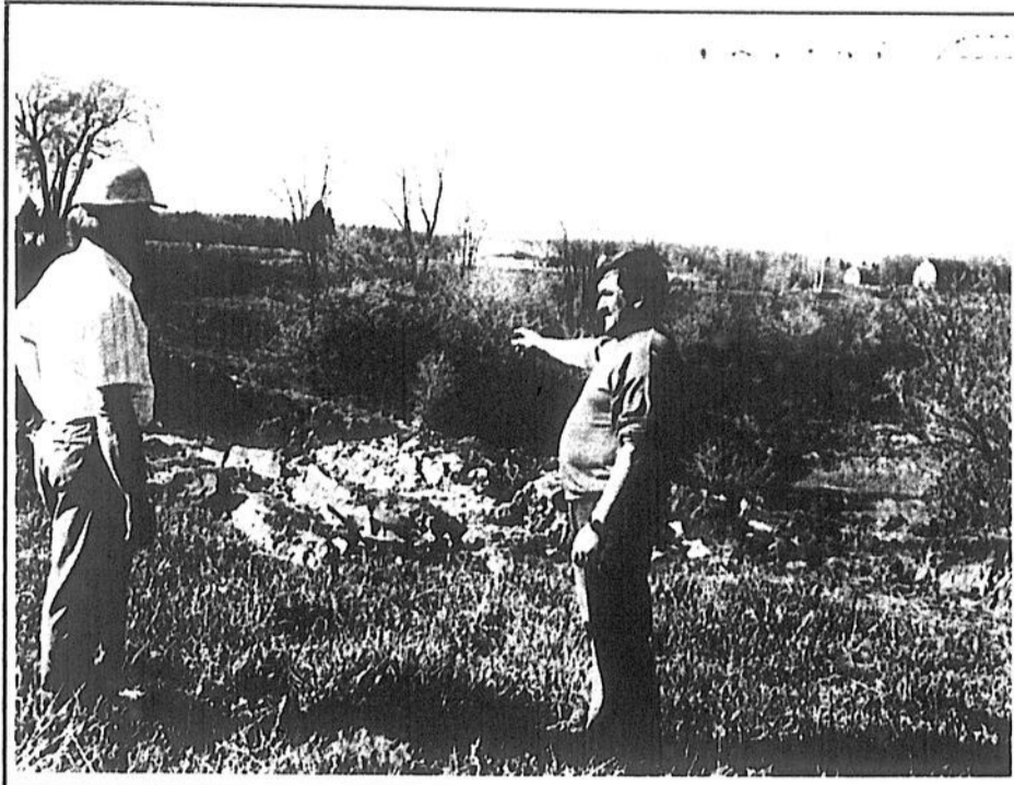
Photo Pierre Bellemare Le glissement de terrain a obstrué la petite rivière Yamachiche. L'inspecteur municipal Maurice Isabelle et M. Claude Villemure ont constaté les dégâts.
