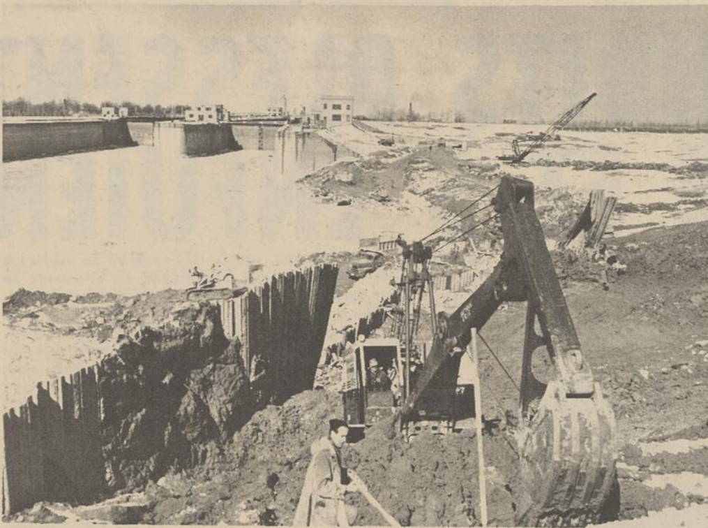
EXCAVATION—Les travaux d'excavation sont en cours à six endroits différents du canal Welland. Il s'agit là d'une besogne préliminaire au doublage du canal entre le Lac Ontario et le Lac Érié. Le gros du travail doit être effectué durant l'hiver lorsque le canal est vide. A l'arrière plan, on aperçoit une des trois écluses qui ont déjà été doublées.
