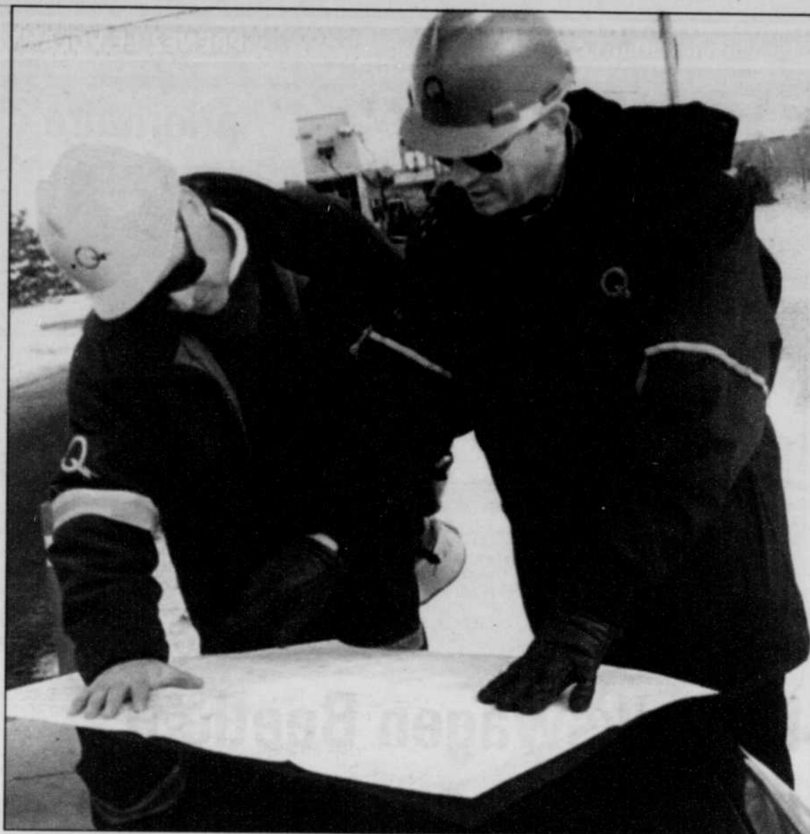
Gaétan Gauvin explique à son collègue Yvan St-Pierre les prochaines étapes de réparations des lignes, sur la rue St-Vallier à Granby. Guy Aubin, au service d'Hydro depuis 30 ans, fait aussi partie de l'équipe de monteurs. photo Richard Chagnon
