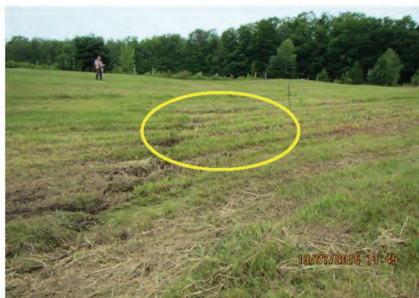
Photo 14 Résurgence à l'emplacement d'un puits de surface identifié par le SIH (site 2).
