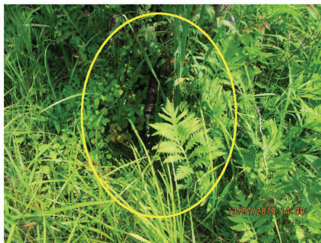
Photo 12 Exutoire d'une source canalisée située à l'extérieur du site 2.
