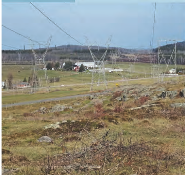
Couloir de lignes de transport à 230 kV entre le chemin du Ruisseau-Le Bourdais et la route 153.
