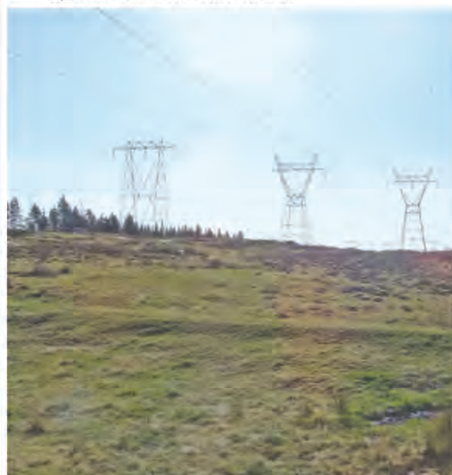
Couloir de lignes de transport à 230 kV à partir du chemin du Ruisseau-Le Bourdais.
