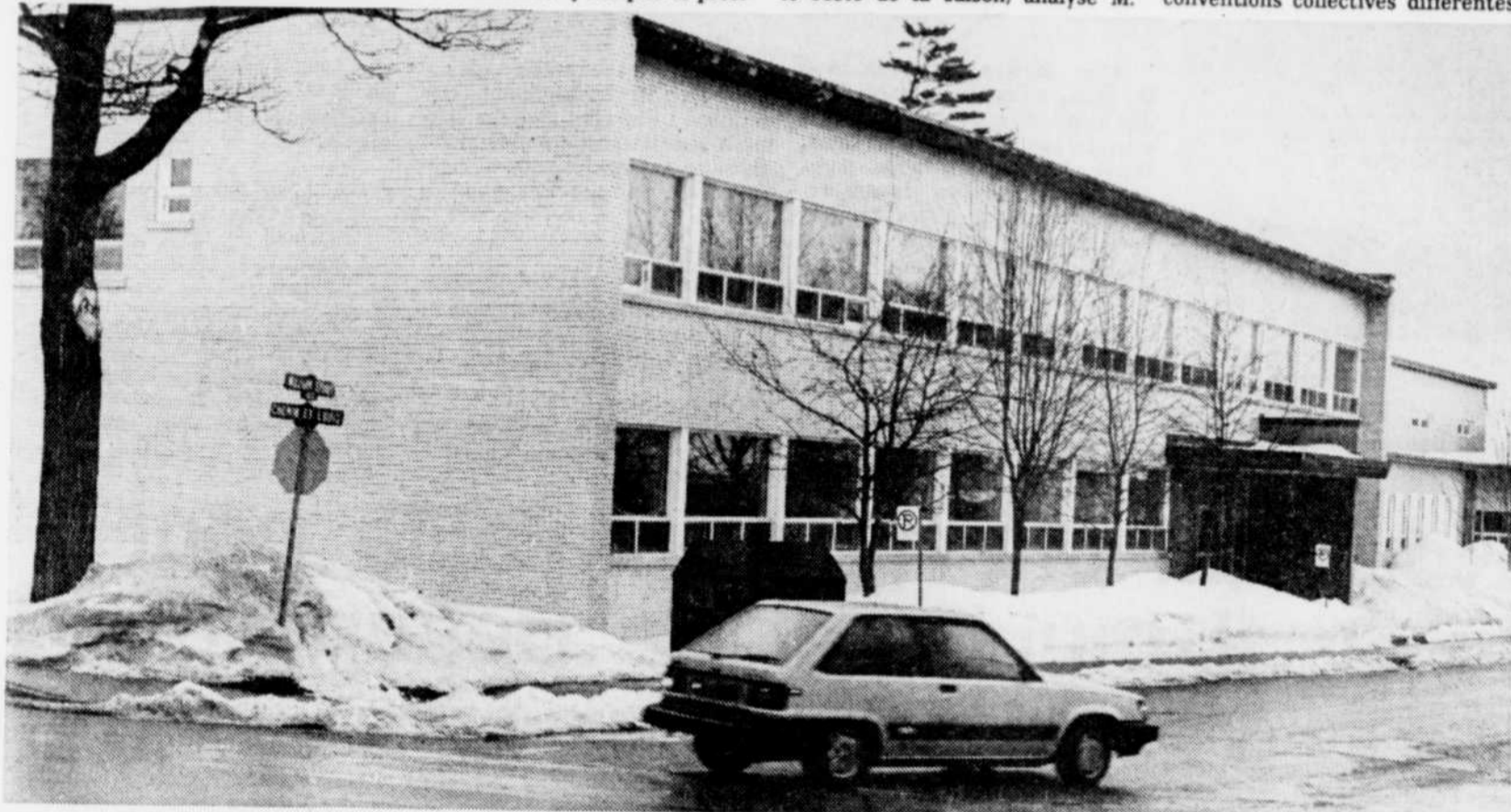
L'école Sainte-Isabelle, une des deux écoles que la ville de Sainte-Foy devait acheter et qui feront l'objet d'appels d'offres de vente. Ecoles Sainte-Isabelle et Ressources
