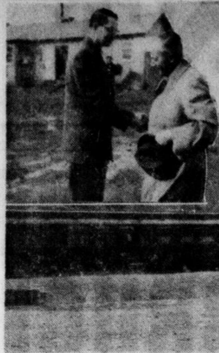
A LA ROUTE DU FER, L'AUDACE A DONNE DES AILES: Ce photo-montage illustre dans quelle nature l'homme a dû se frayer une voie pour mettre à jour les richesses inouïes du Nouveau-Québec et du Labrador. Au point "Mille-80" de la ligne de 350 milles de la Québec North Shore & Labrador Railways, entre Sept-Îles et Schefferville, un avion attend le lieutenant-gouverneur de la province, l'honorable Gaspard Fautoux, qui sera accueilli (photo du haut) par M. François Langlois, maire de Schefferville et responsables des installations électriques du grand centre minier de la région.
