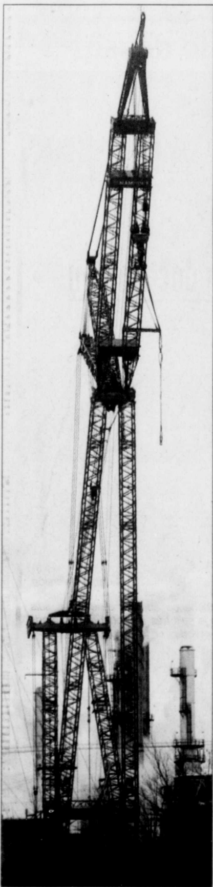
La grue de 420 pieds, l'une des plus hautes grues mobiles au monde.
