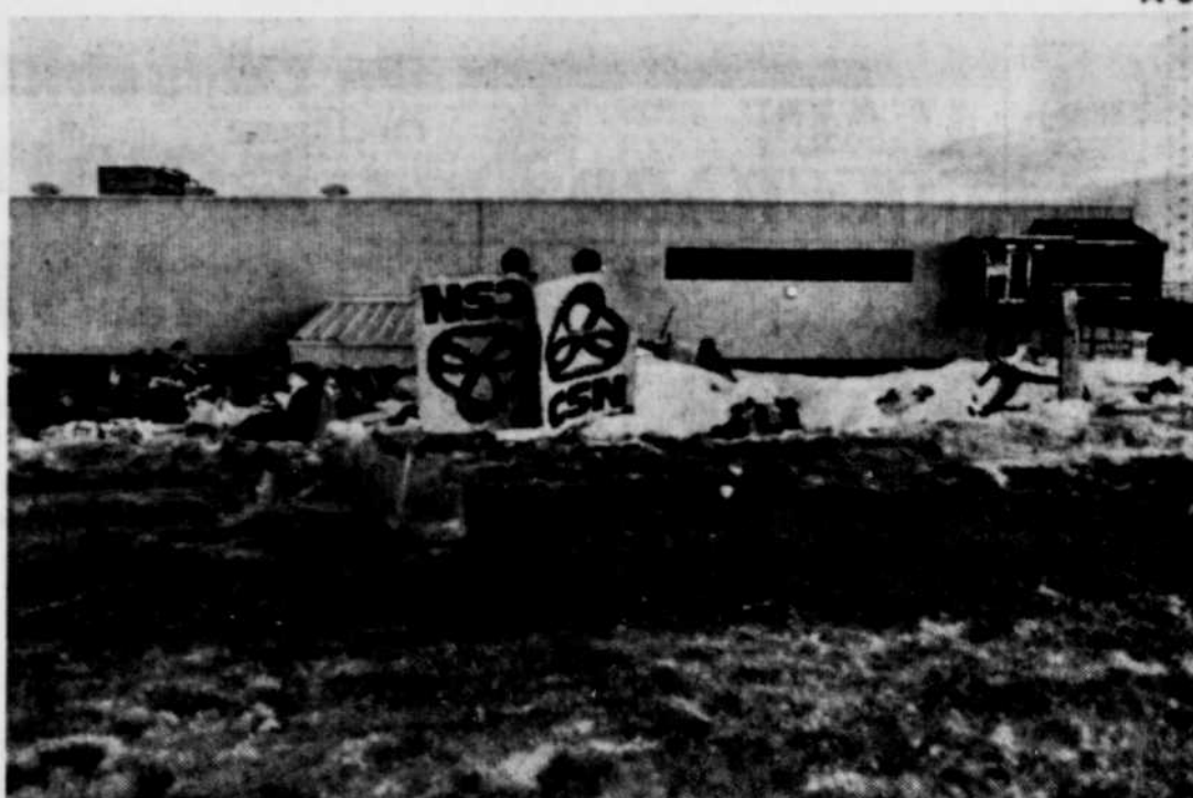
Depuis plus d'un mois, la crise à l'usine de transformation du poisson secoue le village de Newport, dans la Baie des Chaleurs.
