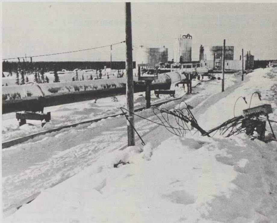
Pour étudier les effets d'un pipe-line sur le pergélisol, un consortium de compagnies pétrolières a créé ce pipe-line expérimental de 700 mètres, à Inuvik.
