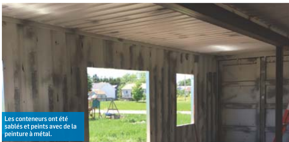
L'entrepreneur Luc Moreau, de Saint-Germain-de-Kamouraska, a modifié les conteneurs, entre autres en perçant les trous des portes et des fenêtres.
