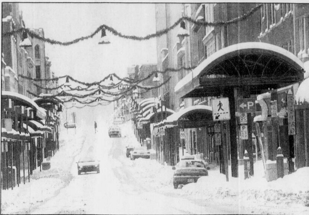
Installées en 1973, les marquises de la rue Wellington Nord devaient être enlevées cette année. Mais voilà que certains conseillers trouvent qu'il s'agit d'une dépense inutile qui doit à tout le moins être débattue.
