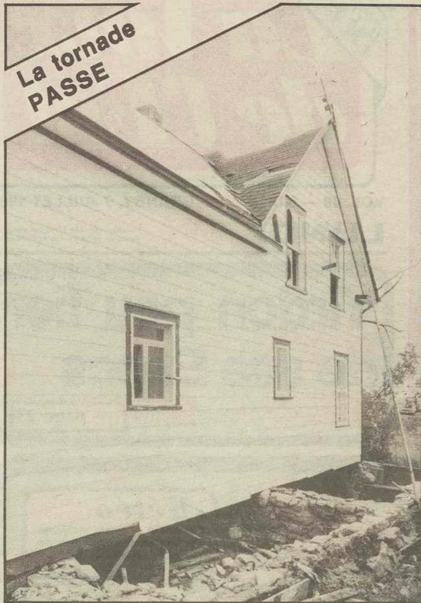
Une maison de Westbury, à 30km de Sherbrooke, a été littéralement arrachée de ses fondations et s'est déplacée de plus d'un mètre sous l'effet de la tornade qui a balayé certains secteurs de la région.
