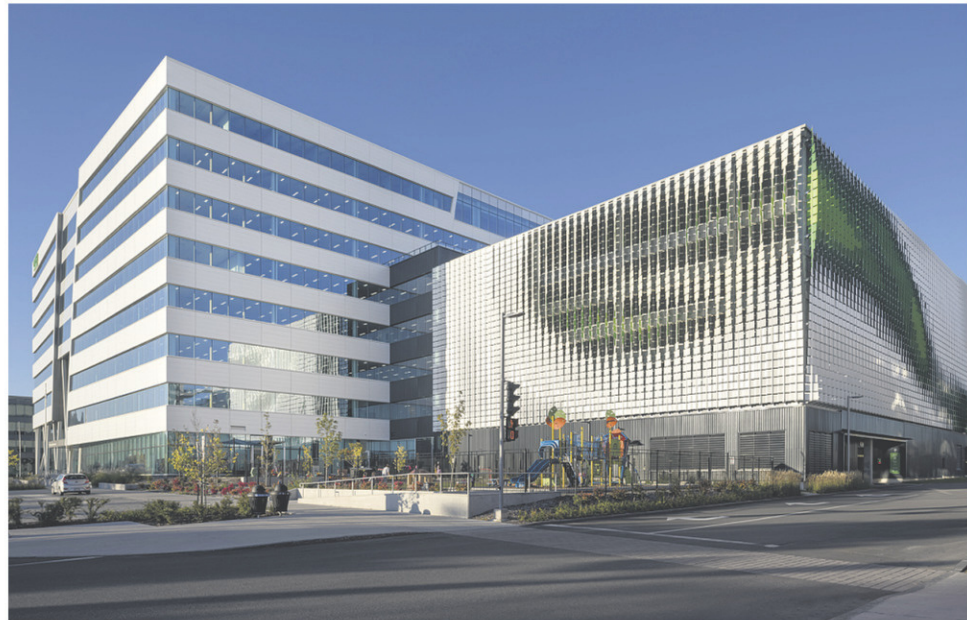
CIMA+ FAIT PARTIE DU CONSORTIUM DE LA CONSTRUCTION DU NOUVEAU SIÈGE SOCIAL DE LA CNESST, DANS L'ÉCOQUARTIER D'ESTIMAUVILLE, À QUÉBEC – PHOTO: STÉPHANE GROLEAU
