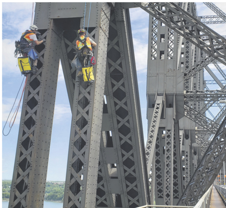
INSPECTION DU PONT DE QUÉBEC
