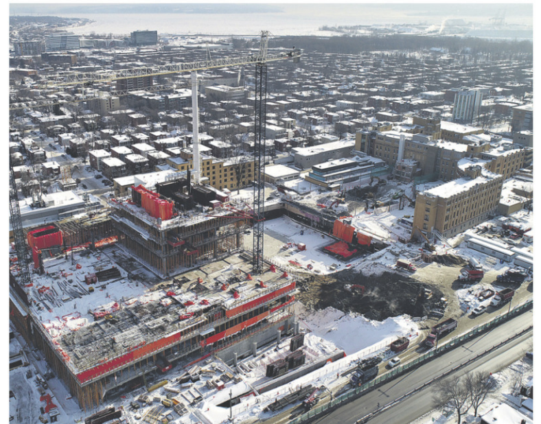
CHANTIER DE L'HÔPITAL DE L'ENFANT-JÉSUS – PHOTO: LE SOLEIL
