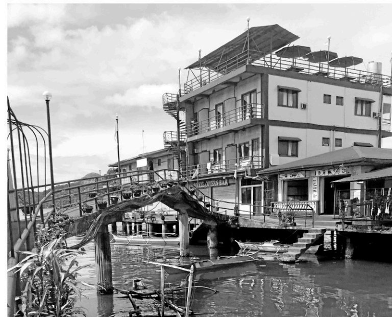
Avec sa terrasse sur le toit, son immense balcon au deuxième étage et un restaurant ouvert sur la mer au rez-de-chaussée, le Seadive Resort a été conçu pour les gens qui aiment vivre dehors.
