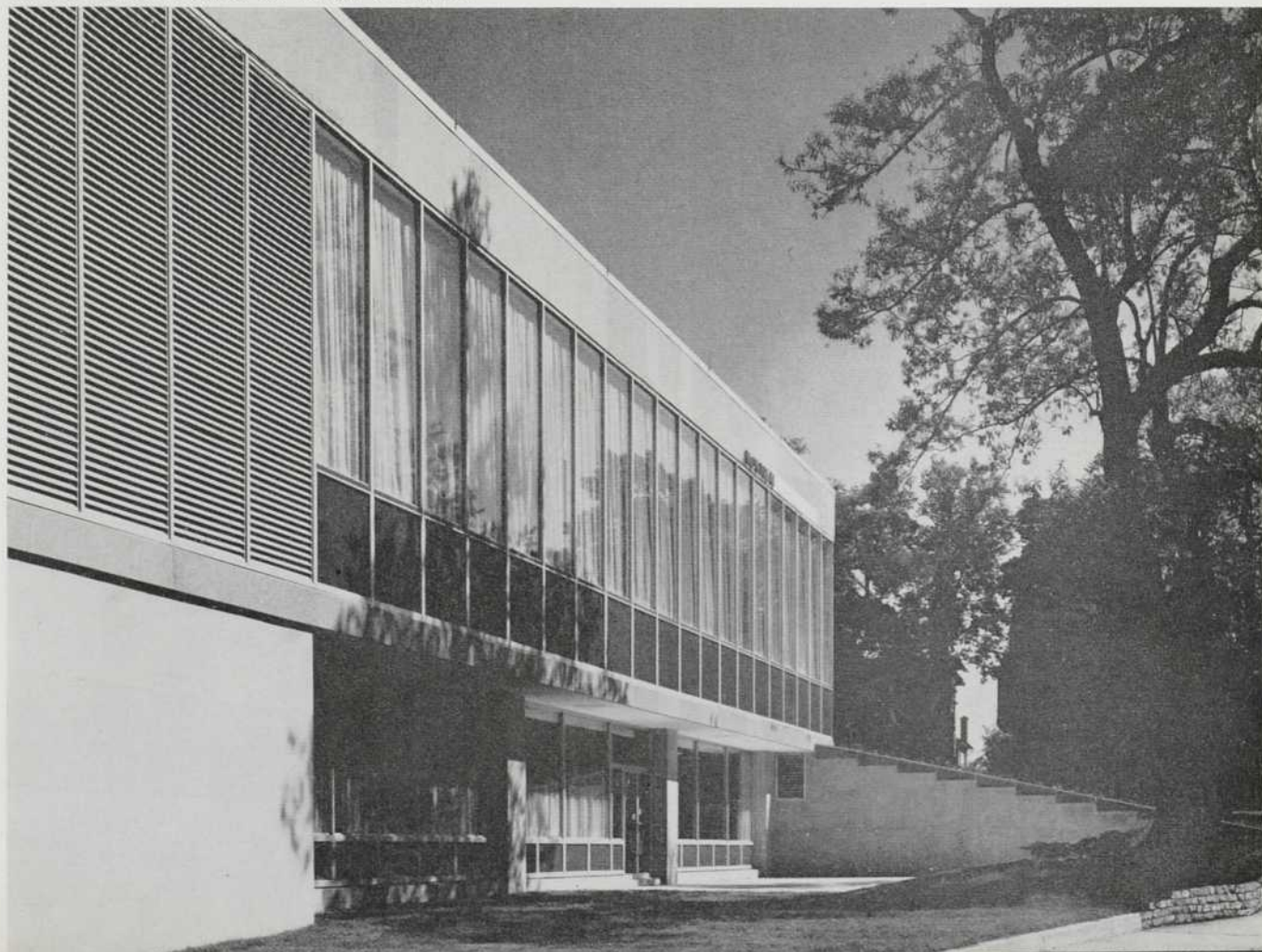
Elévation arrière et entrée des services en sous-sol
