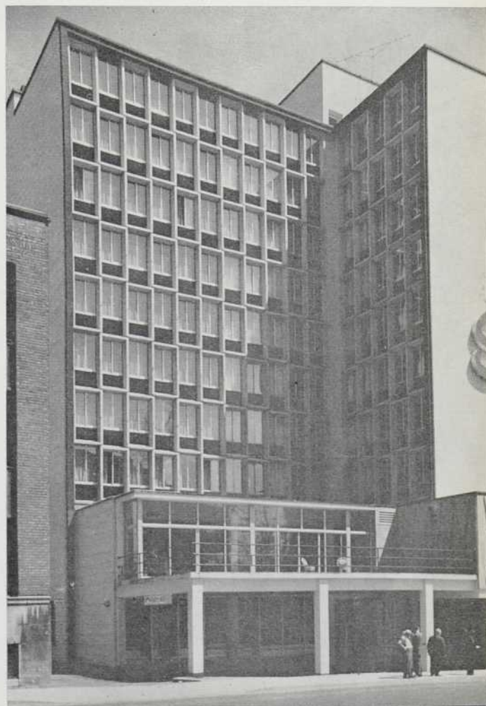
Aspect de la façade ouest de la terrasse.
