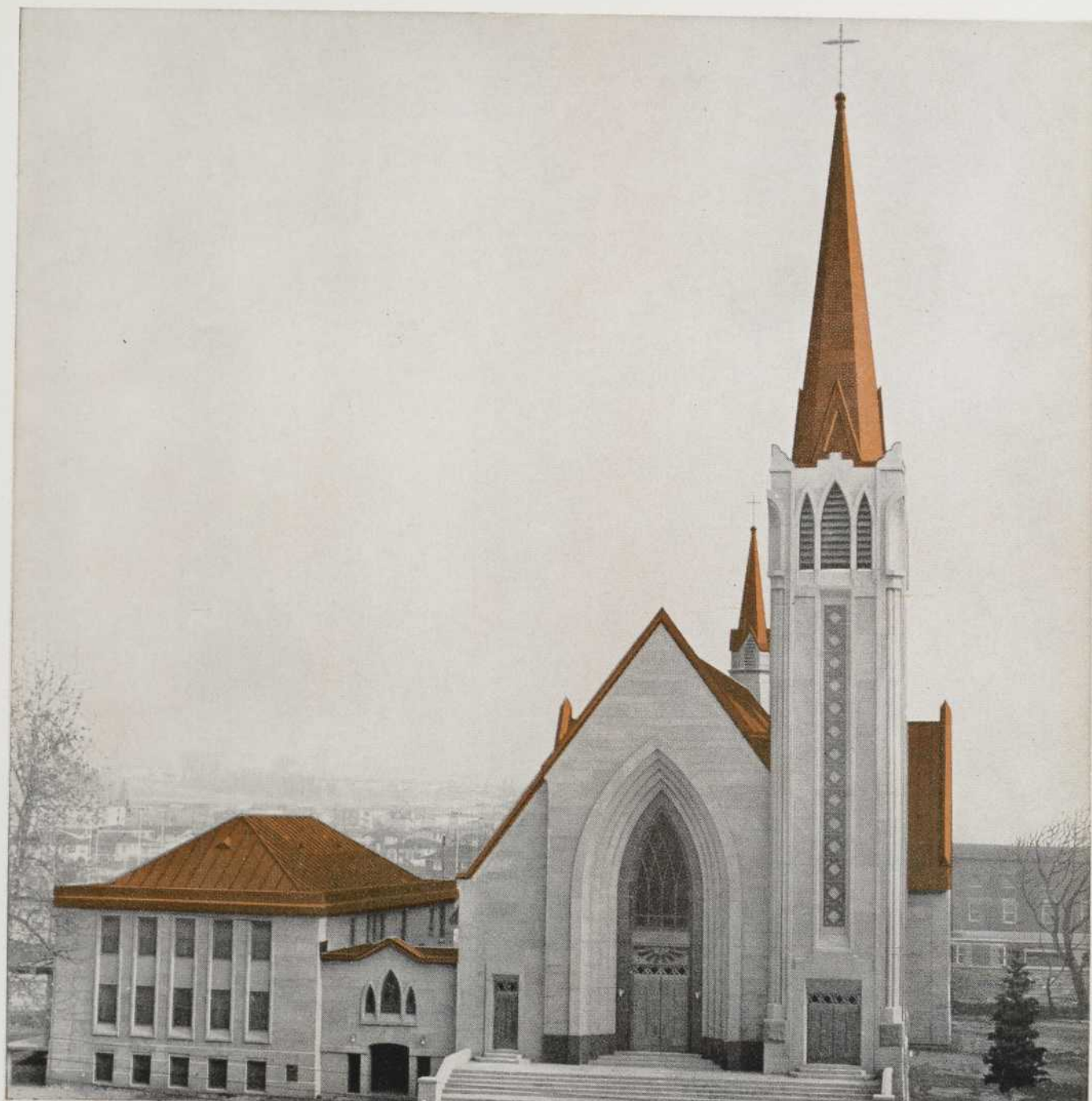
Architecte: René Blanchet Entrepreneur-couvreur: Eug. Falardeau Limitée Fournisseur: Rosco Metal Products Limited
