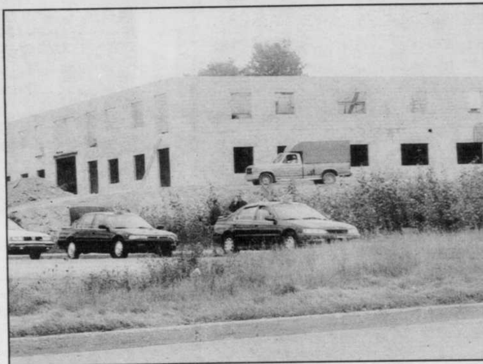
Georges Landry aimerait construire une salle de repos entièrement vitrée sur cet édifice de 58 logements en construction à l'angle des rues Simonds et Bourget, à Granby.
