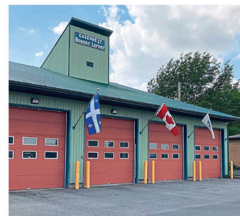
La caserne de pompiers de Sainte-Clotilde.
