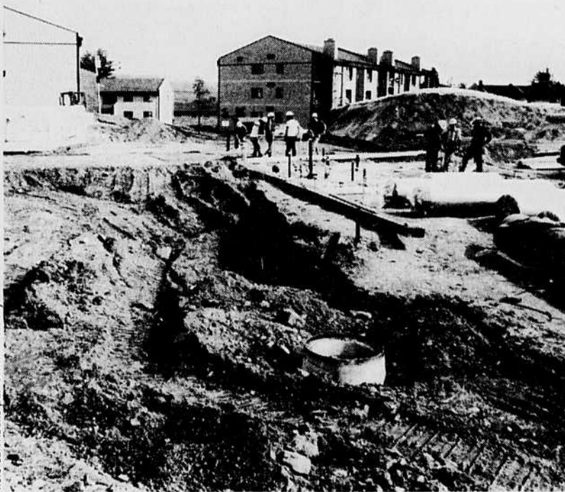
Les travaux d'aménagement du «Top golf» impliquent des déboursés de 750 000 $.
