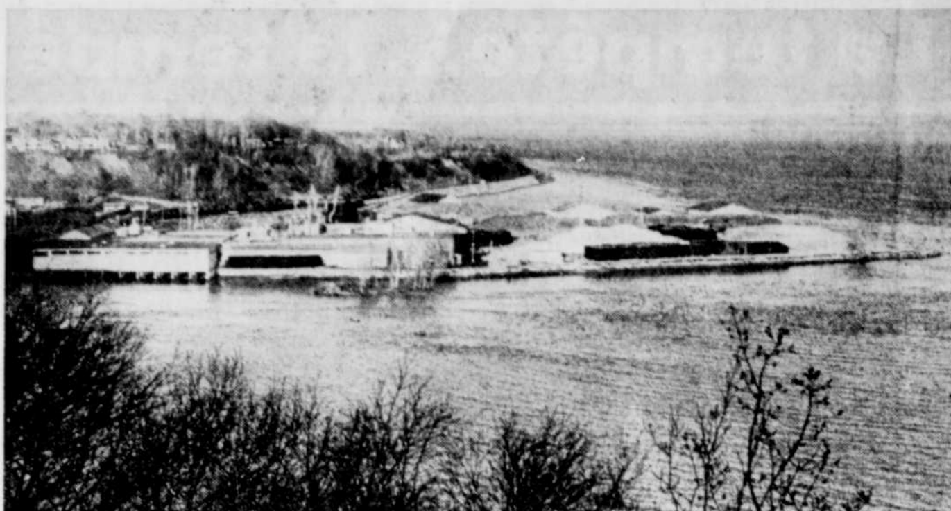
Semaines de 5 jours, en février, chez Matériaux de construction Domtar, à Donnacona.
