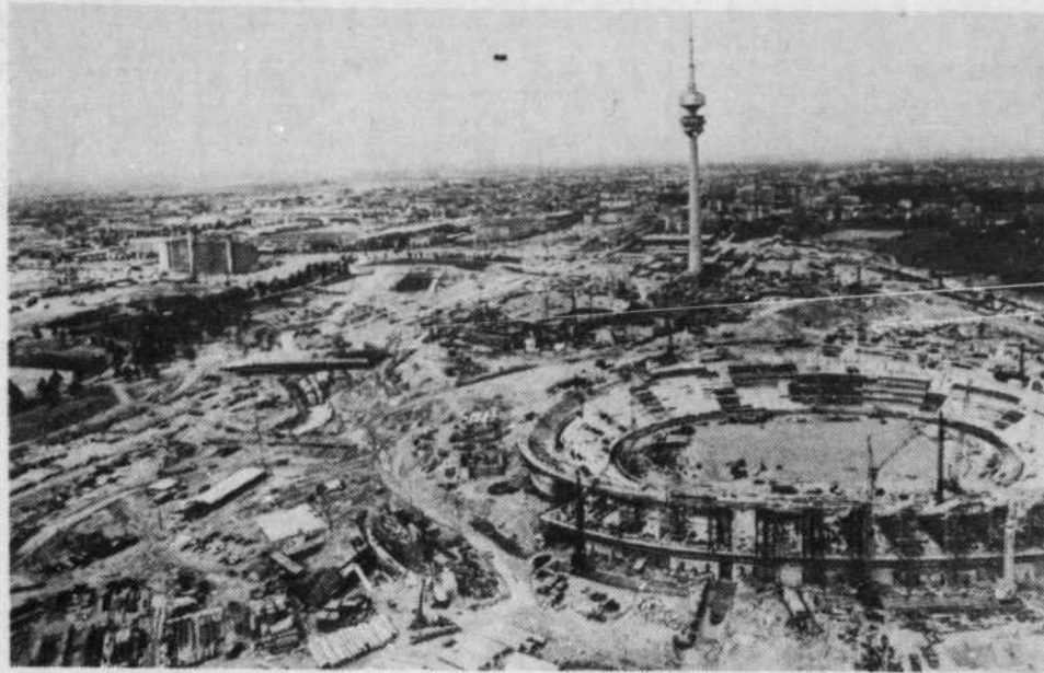
Une ville se prépare: voici le centre du terrain olympique 25 mois avant le début des Jeux olympiques de Munich. Au premier plan, le stade olympique; à gauche, derrière, le Hall des sports; à droite, à côté, le Stade nautique; à gauche, les installations du village olympique féminin.
