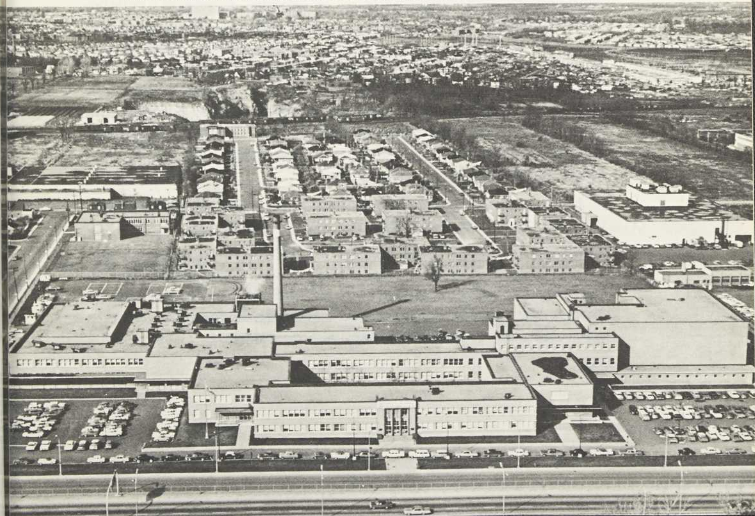
Administration et studios de l'Office national du film à Montréal
