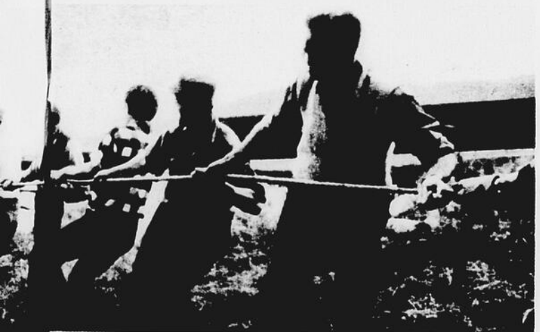
Ho! hisse! On souque à la corde pour mettre debout la deuxième des fermes.
