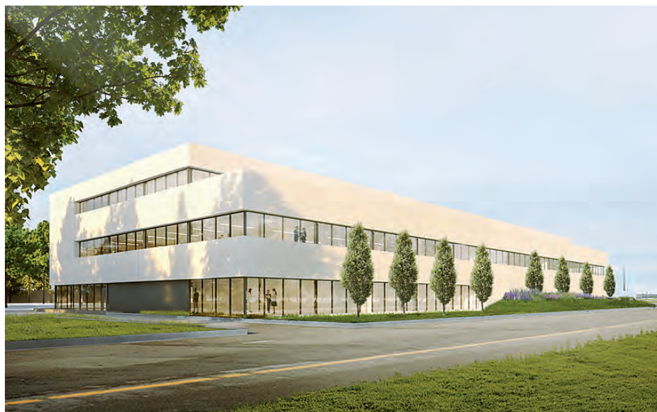
Une vue du nouveau Complexe médical Saint-Eustache qui accueillera, à partir du mois de novembre, l'ensemble des occupants de la Polyclinique Saint-Eustache.
