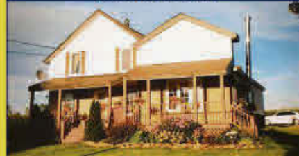
Cottage 3 c.c. avec de grandes pièces + garage 2 étages.
