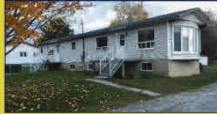
Duplex avec garage et grand terrain.
