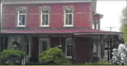
Cottage 4 c.c. tout brique. Plusieurs boiseries et un garage.
