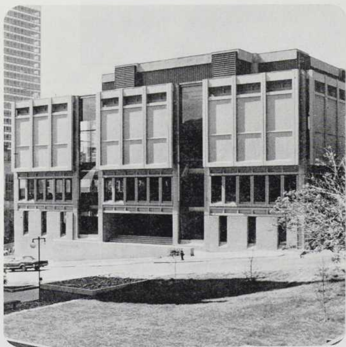
Centre des Etudiants, Université McGill, Montréal. Architectes: Affleck, Desbarats, Dimakopoulos, Lebensold, Sise. Entrepreneur: Douglas Bremner Contractors & Builders Ltd.
