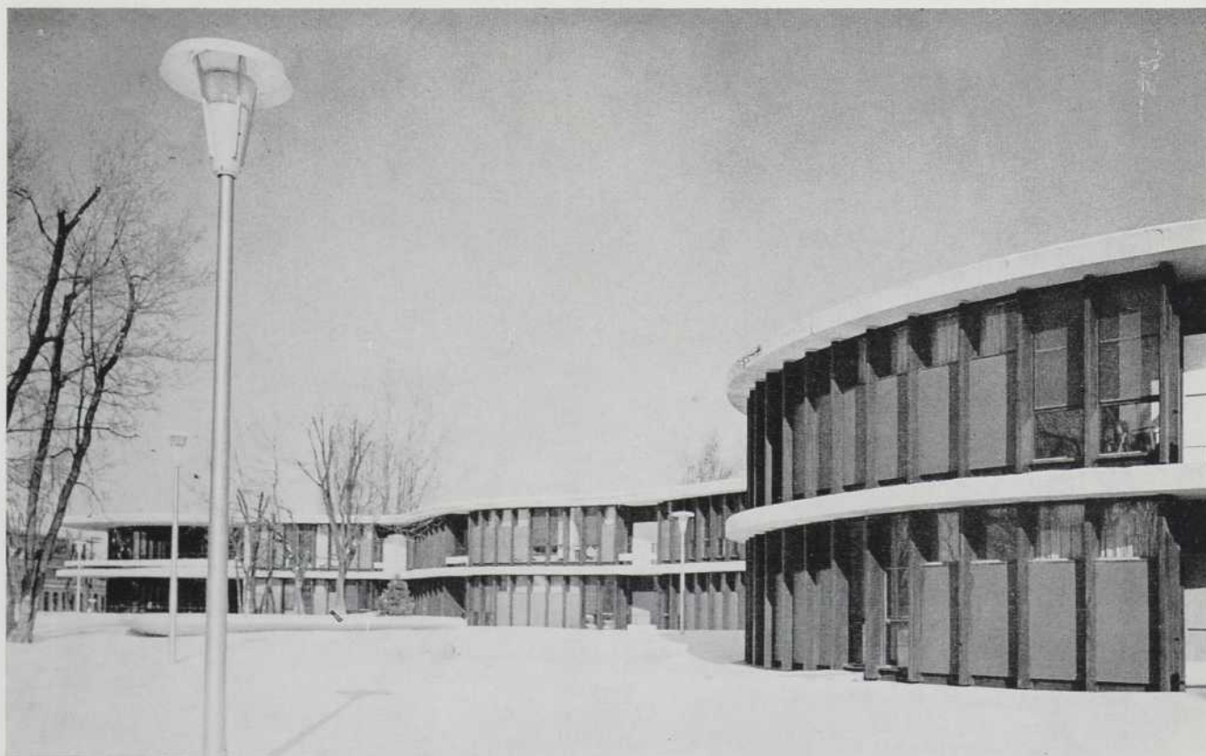
vue partielle de la façade sud
