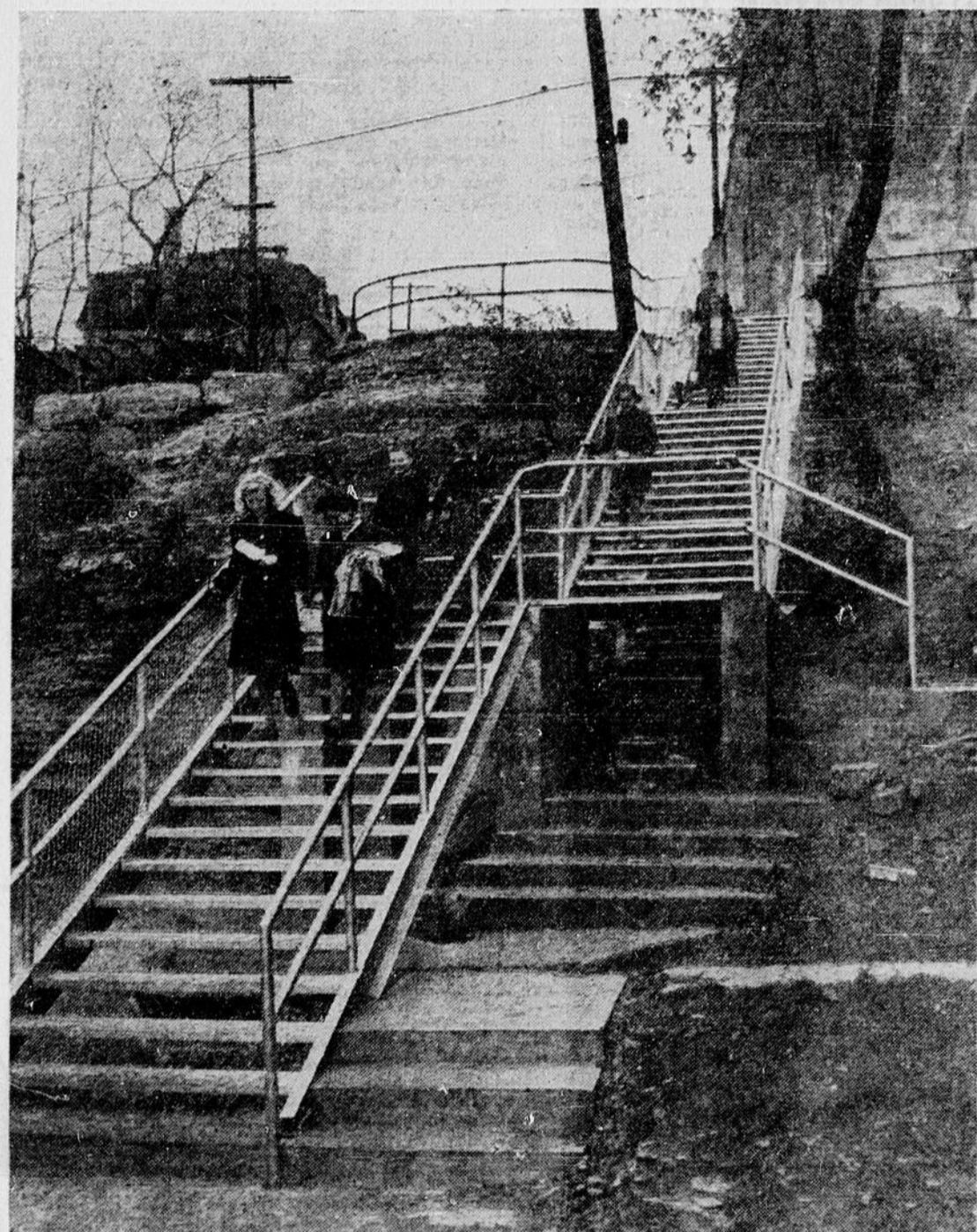
L'installation de nouveaux escaliers en acier, au bout des rues Primrose et Empress, a fort réjoui les citoyens du quartier, qui se plaignaient du mauvais état des escaliers de bois qui devenaient dangereux. Au cours d'une cérémonie tenue à la tête des escaliers de la rue Empress, plusieurs personnes ont exprimé leur gratitude à l'échevin Daniel McConn qui, par son dévouement a obtenu ces escaliers. Ci-dessus, l'un des escaliers, installé au pied de la rue Primrose.
