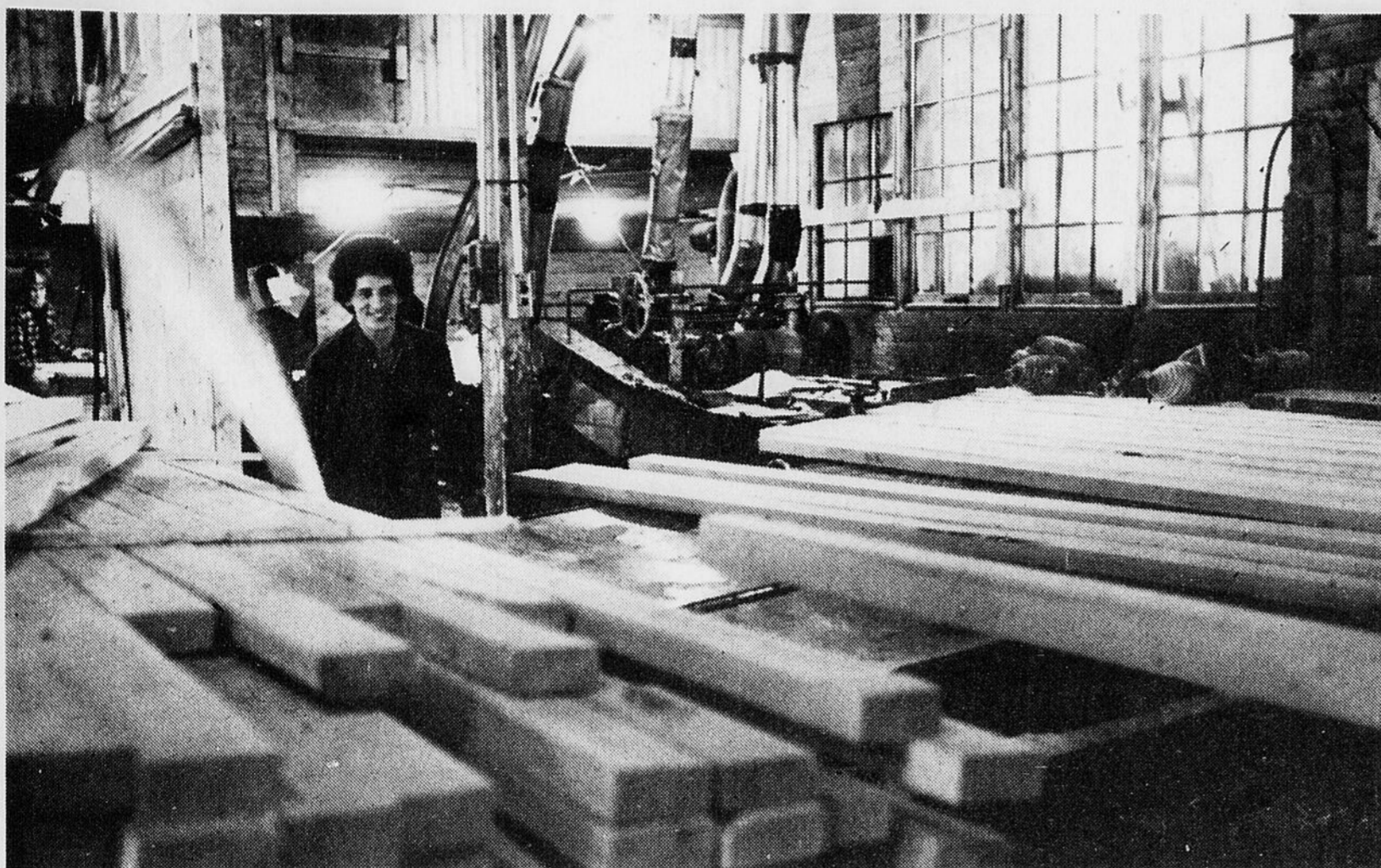
MARCHE PROVINCIAL — Le bois de construction produit chez Lamontagne Ltée est d'abord vendu à Québec et à Montréal.
