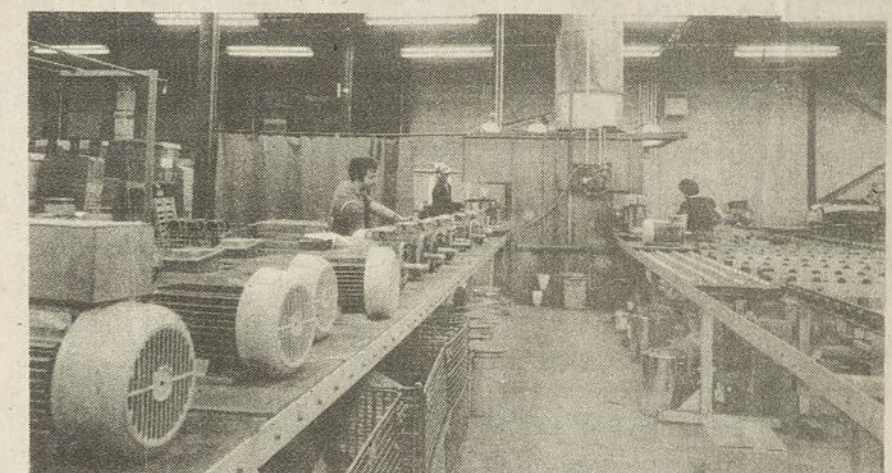
Des milliers de moteurs électriques passent sur cette chaîne d'assemblage toutes les semaines.
